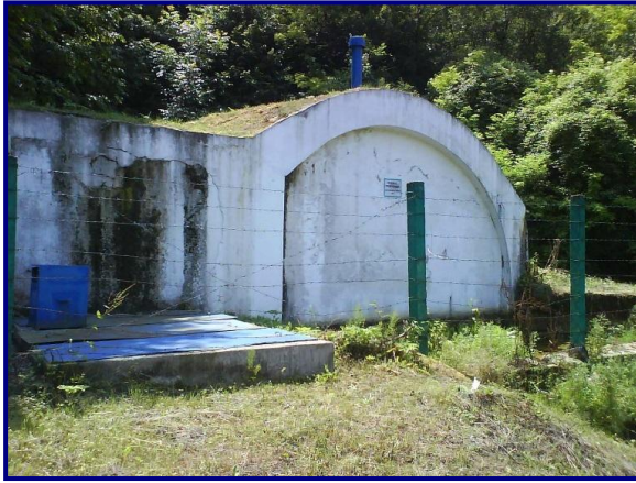
Слика 3. Каптажна грађевина врела „Пакље”
