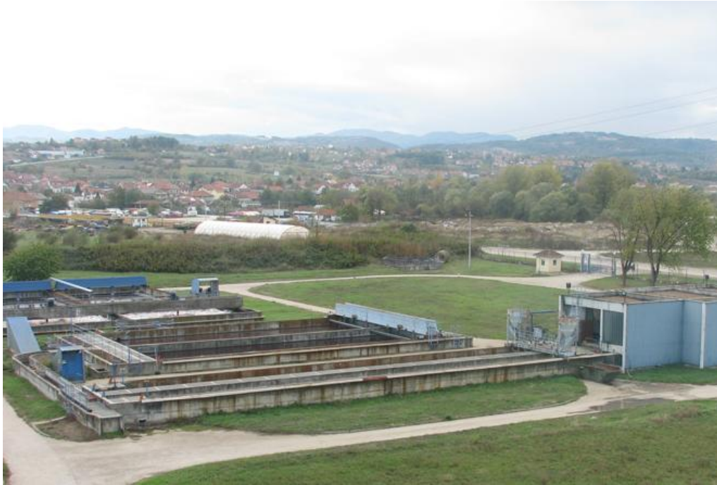
Слика 13. Постројење за пречишћавање отпадних вода ППОВ „ Горић“
