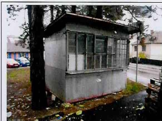
Pogled sa severne strane
