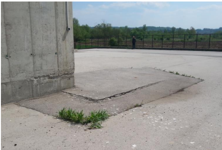
Слика 14.4-1. Слегање коловоза и пуцања асфалта на претоварној рампи и платформи ТС
