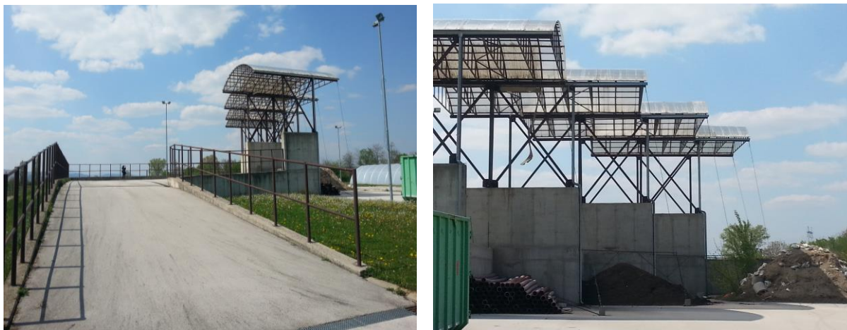
Слика 14.4-4. Надстрешница изнад претоварне рампе на ТС
