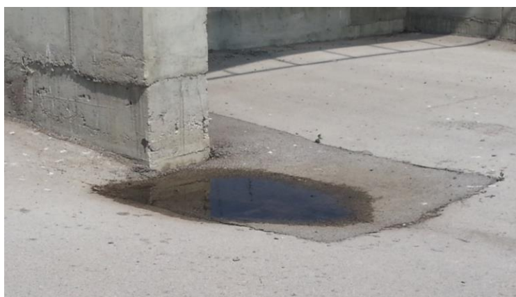
Слика 14.4-2. Слегање коловоза и пуцања асфалта на претоварној рампи и платформи ТС
