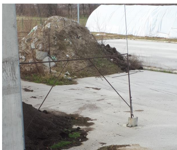
Слика 14.4-3. Постављене металне конструкције од заварене армирачке арматуре између места предвиђених за аброл контејнере
