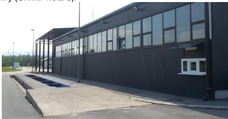
Слика 4.5.2-9. Вагарска кућица у оквиру хале за сортирање и балирање секундарних сировина и колска вага
